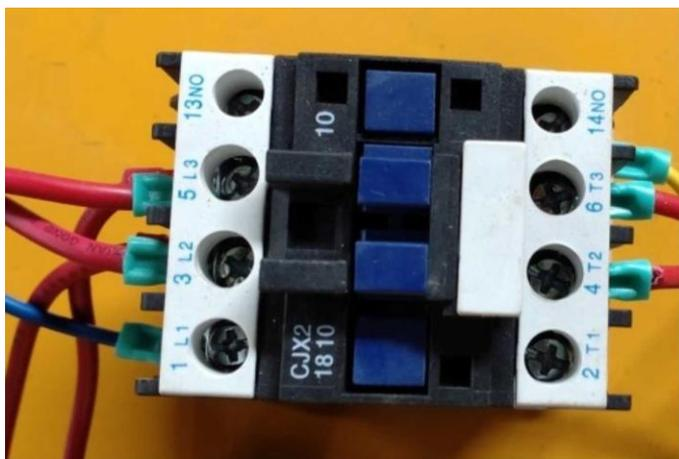
Контактор 1810 для нагревателя. Слева (красные) снизу на 3 и 5 поступает питание 220 В. от автомата ввода, верхние красные для питания электродвигателя маслостанции через контактор 1210. При замыкании контактов питание через 4 и 6 (красные) подается на нагреватель через разъём (5 и 6). Слева синий внизу А1 питание управляющей цепи контактора. Желтый внизу А2 от терморегулятора, замыкает цепь управления. Замыкание цепи происходит в терморегуляторе.
